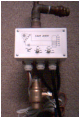
Delta-T Controller & TACO 008
